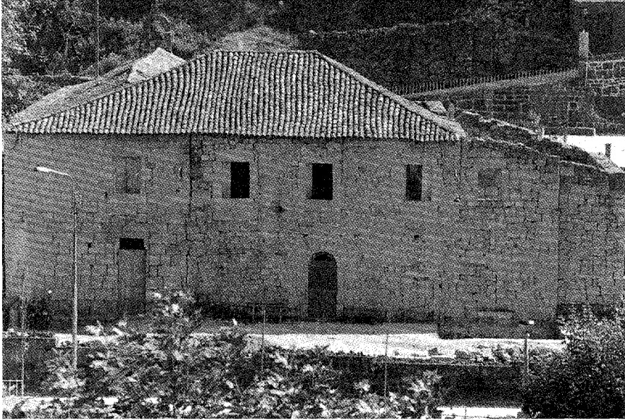
Lâm. 14. Vista geral da fachada Norte, virada ao rio Vouga.
