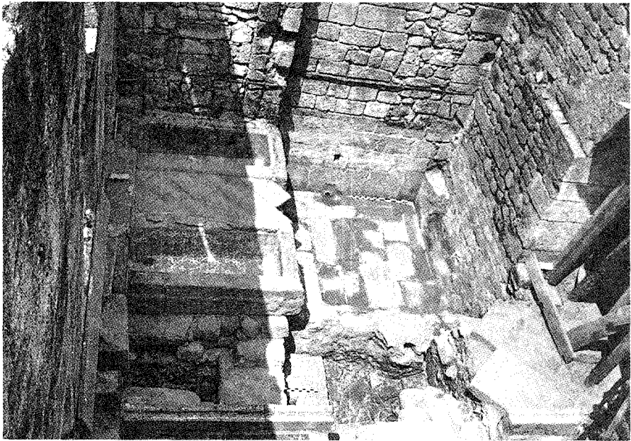
Lám. 7. Sala das banheiras, vendo-se as estruturas de P4 e P5.
