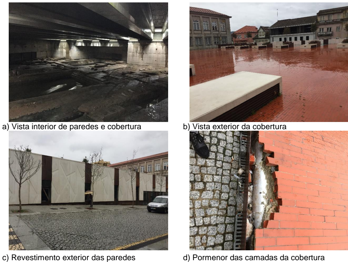
Figura 3.13 – Elementos opacos da envolvente
